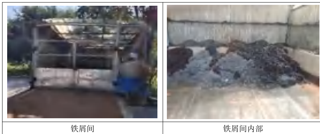
图 4.1-4 一般工业固体废物暂存设施
