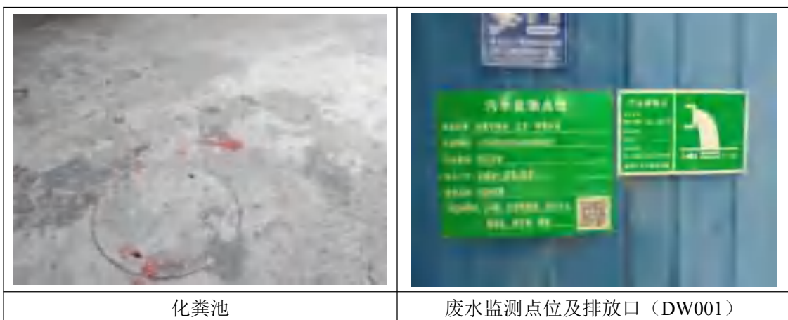
图 4.1-2 化粪池及废水排放口
