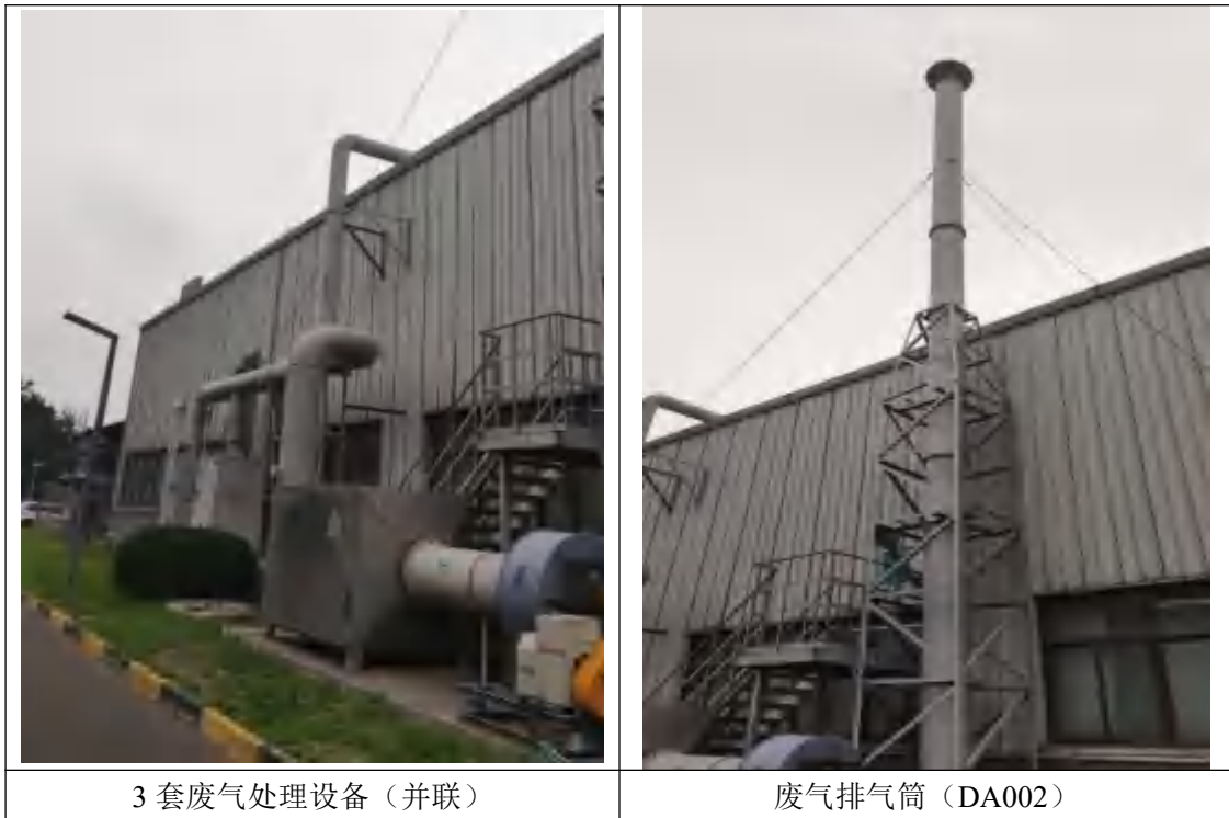
图 4.1-1 废气处理装置及排气筒
